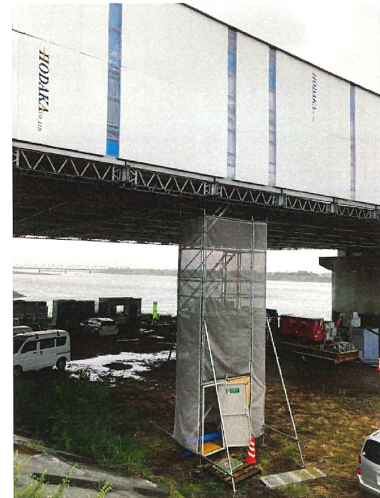
クイックデッキ 朝顔の支柱と手摺は クイックデッキ材(3S)を使用
